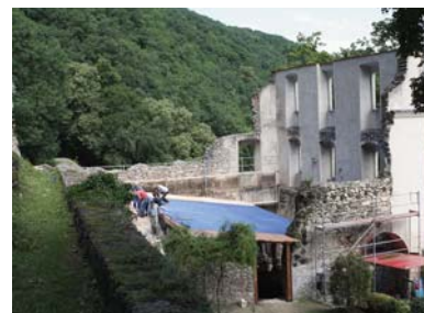
Výstavba sociálneho prístrešku a sanácia múra v kláštore
